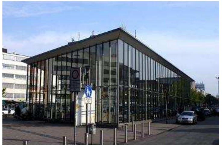
Fahrradparkhaus in Münster nahe Hauptbahnhof
